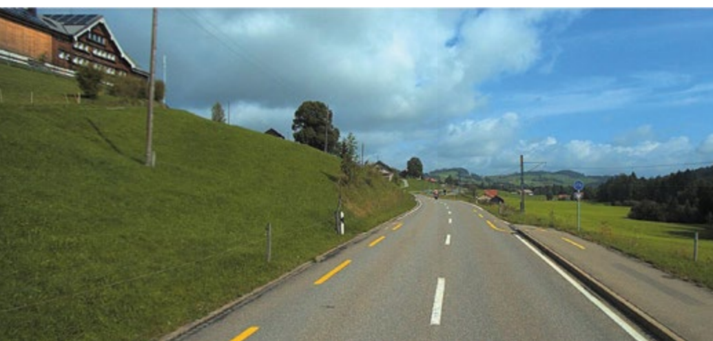
Lücke in der Veloführung zwischen Waldstatt und Urnäsch
