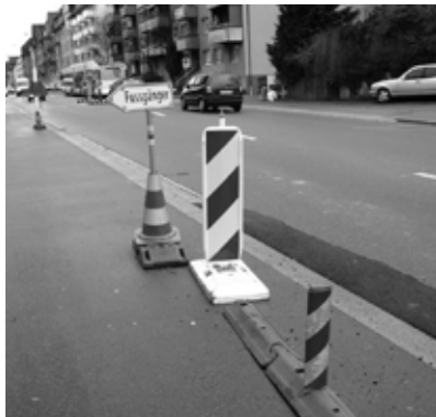
Provisorische Abschrankung mit Schwellen im Heiligkreuz
