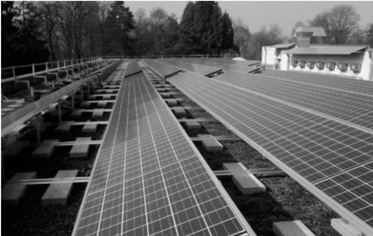
Photovoltaikanlage auf dem Parkhaus des Kurzentrums in Rheinfelden
