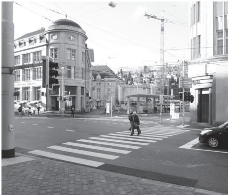
Abb. 5: Neuer (alter) Fussgängerstreifen
