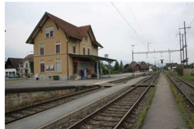
Bild Heute: Eine längst fällige Unterführung wird mit der Neugestaltung realisiert.
