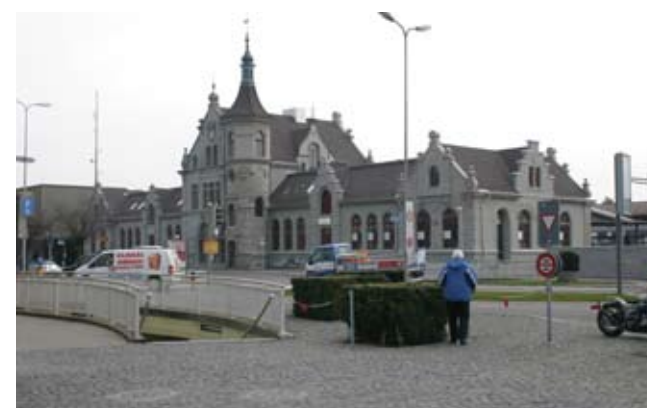
Foto Unterführung: Der Zugang zur Altstadt ist nicht optimal. Leider wurde die Chance zur Realisierung einer oberirdischen Querungsmöglichkeit nicht genutzt.
