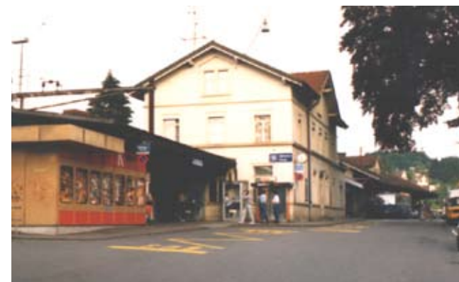
Vor dem Umbau: Das ehemalige Aufnahmegebäude musste - ebenso wie der Güterschuppen - dem neuen Bahnhofgebäude weichen.
