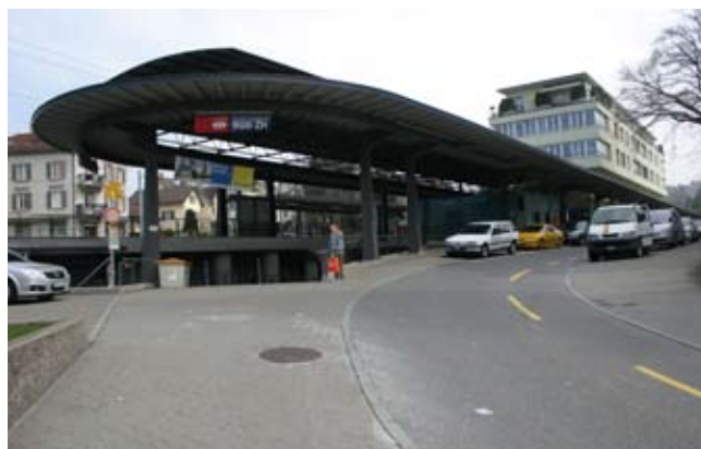
Das geschwungene Perrondach schmiegt sich dem Gleisverlauf an und verbindet Haus- und Mittelperron mit dem Bushof.
