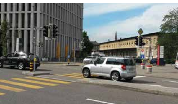
Künftige Autobahn-Ausfahrt von der Teilsperre auf die Geltenwilenstrasse
