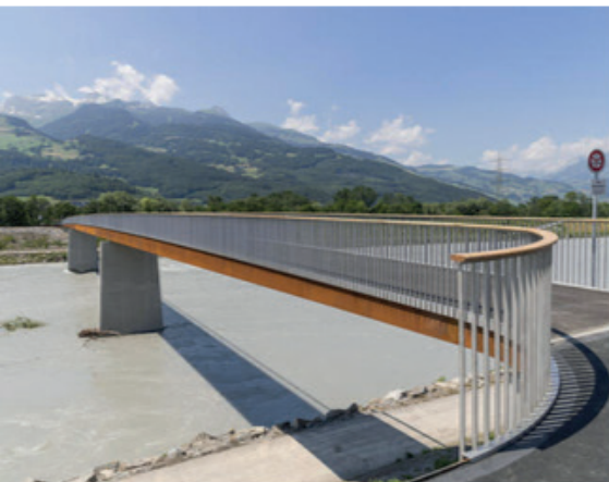
FUSS- UND VELOVERKEHRSBRÜCKE BUCHS-VADUZ (FOTO: LIEWO)
