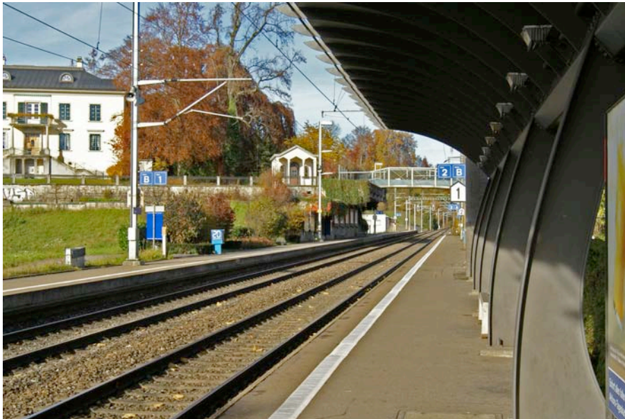
Jona Perrons, ungenügender Witterungsschutz
