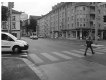
Bild 2: Ein Beispiel einer entdeckten Schwachstelle: Bei der Einfahrt von der Splügenstrasse in die Rorschacher Strasse übersehen die AutomobilistInnen nicht selten das «Grün» der FussgängerInnen.
